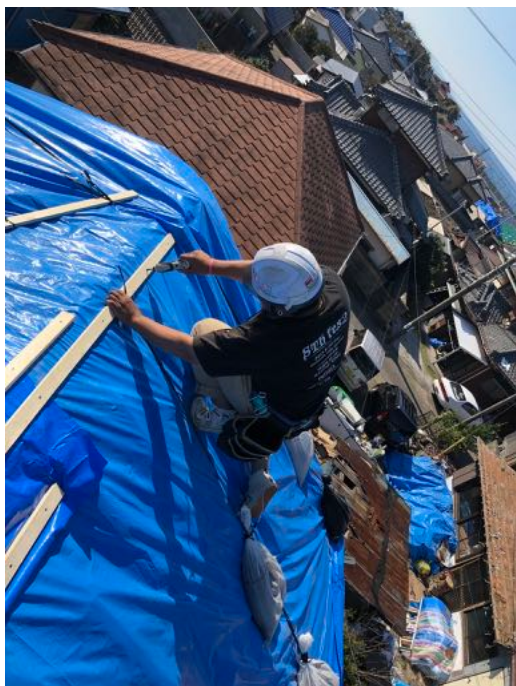
写真3 施工風景 作成した部品の上から必要に応じて木材で留めたりもする。
