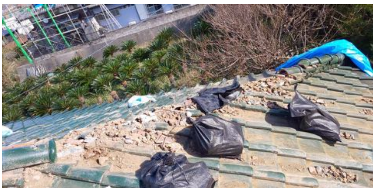
写真4 施工後風による被害例 ブルーシートが飛ばされやり直しの必要が出る家々が増える。
